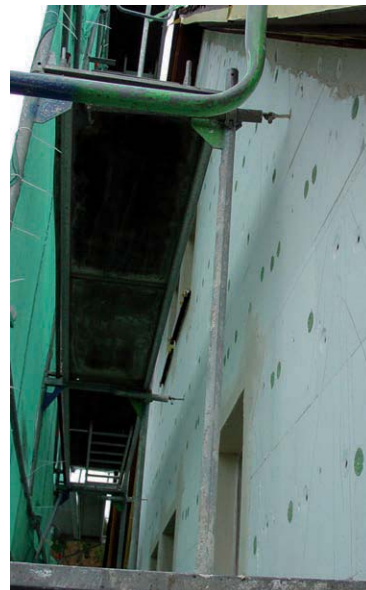
Bild 6. Befestigung eines Arbeitsgerüsts mit langen Ösenschrauben bei Montage eines WDV-Systems
