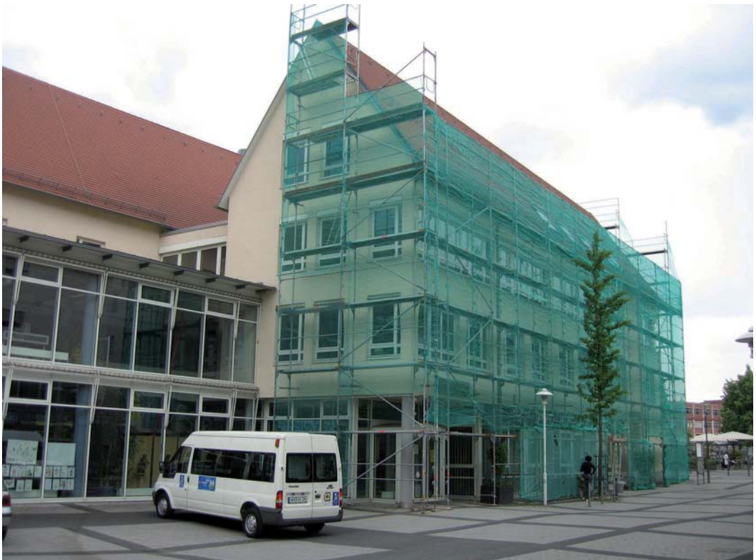
Bild 3. Fassadengerüst mit engmaschigem Netz
